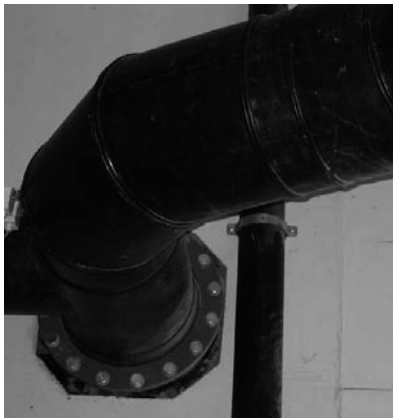
Bild 1: Verlegung mit Akatherm-Wanddurchführungen
