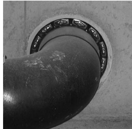
Bild 2: Verlegung mit Ringraumdichtung
